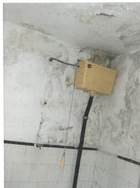
Foto n.º 4 – Interior da instalação sanitária
