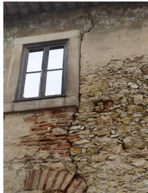
Foto n.º 2 – Vista da fachada que dá para a Travessa do Pomar
