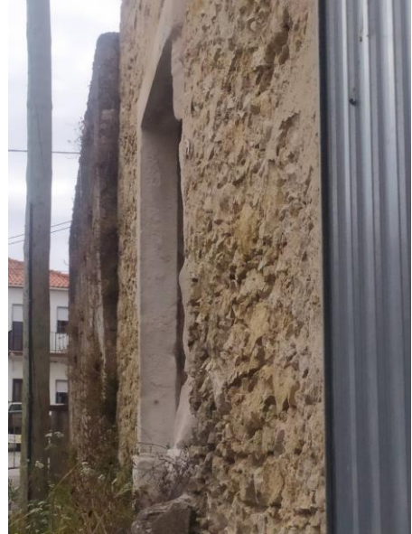
Foto n.º 4 – Vista da fachada que dá para a Travessa do Pomar Vista da pendente
