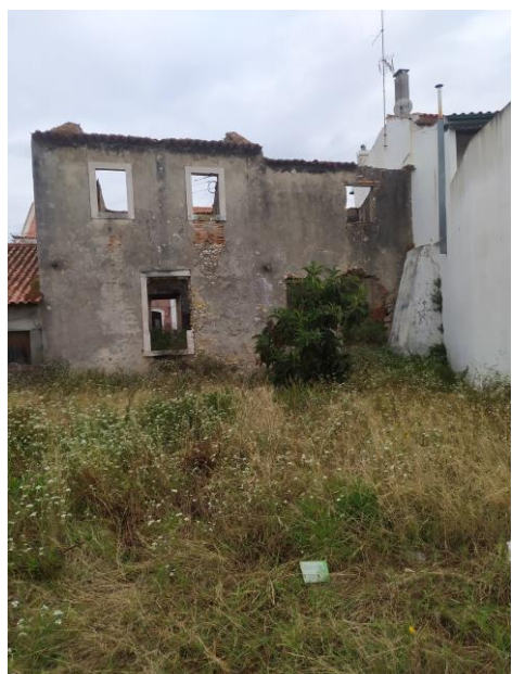
Foto n.º 5 – Vista da fachada que dá para a rua 1º de Maio
