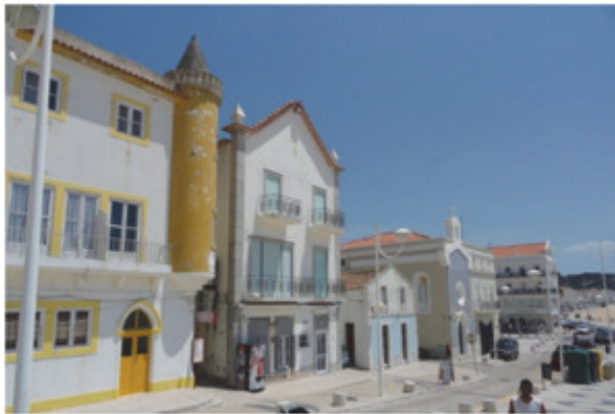
Figura 3 - Vista do edifício a partir da Marginal.
