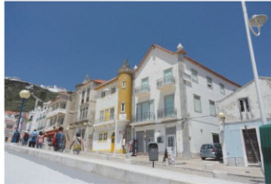
Figura 2 - Vista do edifício a partir da Marginal.
