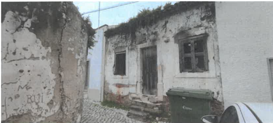
Foto n.º 1 – Vista da fachada para a Rua de São Sebastião, n.º 4
