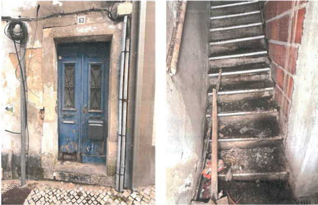
Figura 1 - Porta de entrada e escada de acesso ao 1.º andar e sótão.
