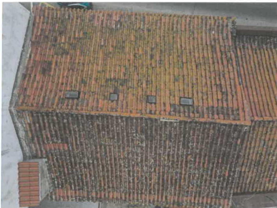
Figura 7 - Cobertura do edifício, lado norte.
