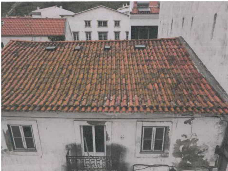
Figura 6 - Cobertura do edifício, lado sul.
