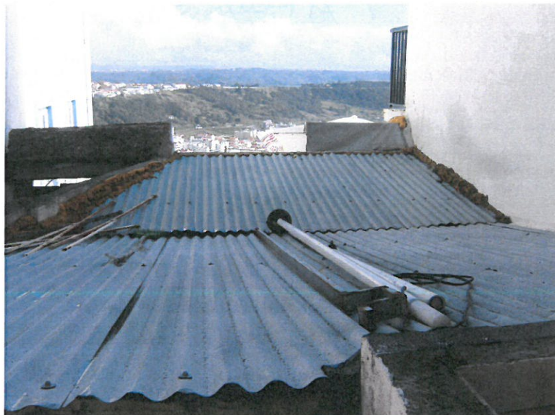
Foto n.º 1 – Vista atual da cobertura
