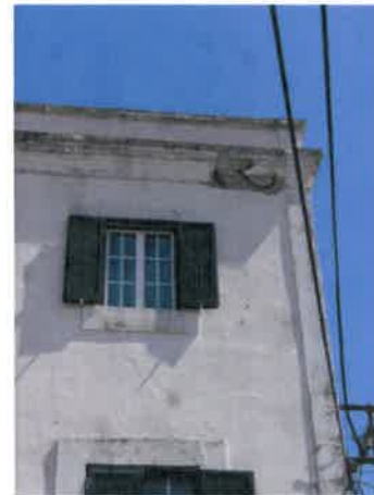
Foto n.º2 – Friso da platibanda
