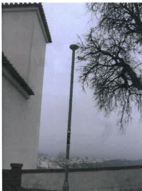
Foto n.º 6 – Fuste de iluminaria sem campânula
