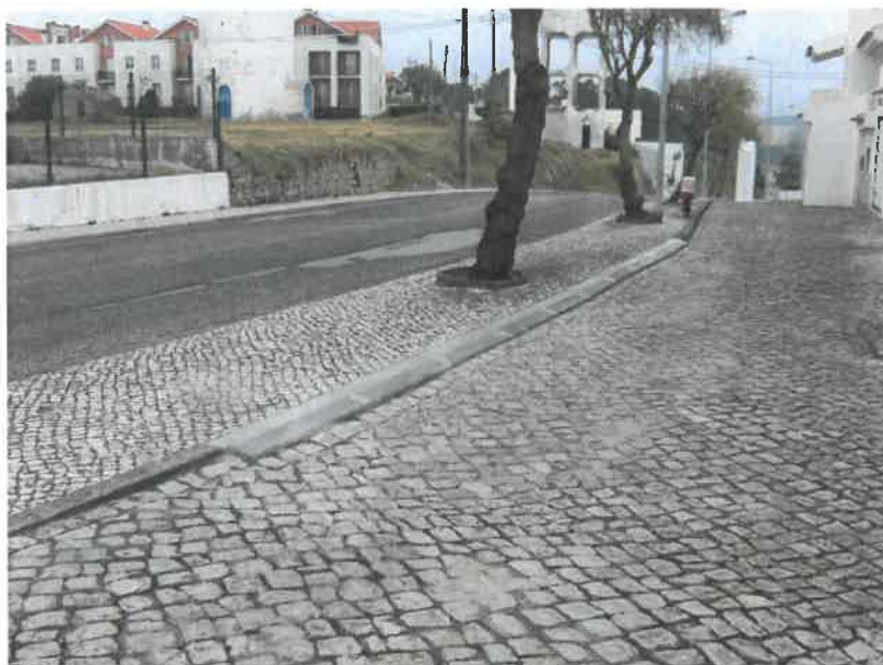
Foto n.º 1- Lancel em betão
