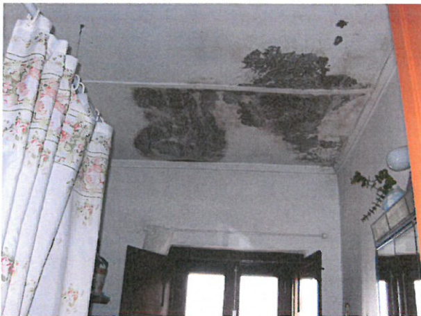
Foto n.º 3 - Interior da instalação sanitária
