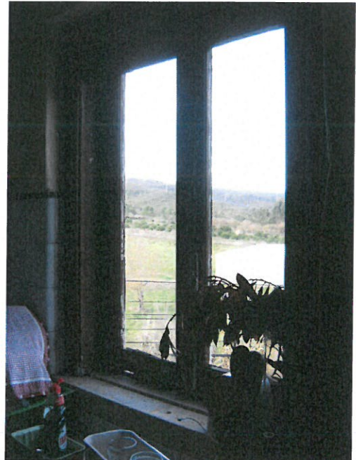
Foto n.º 2 – Vão de janela da cozinha
