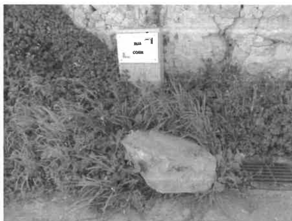
Foto n.º 3 – bloco sobre arruamento
