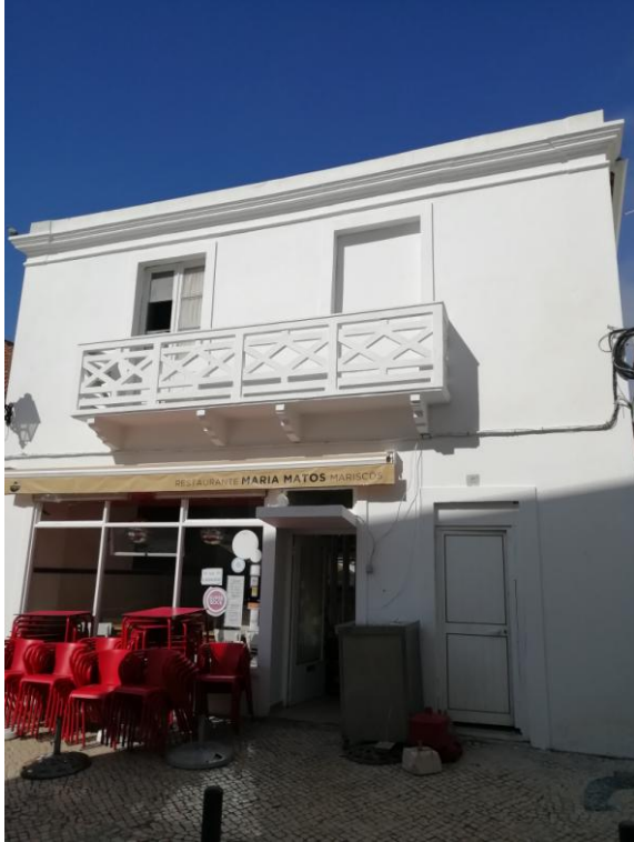
Foto n.º 1 – Vista da Fachada Nascente
