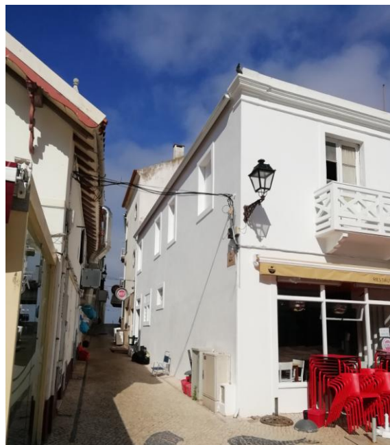
Foto n.º 3 – Vista da Fachada Sul
