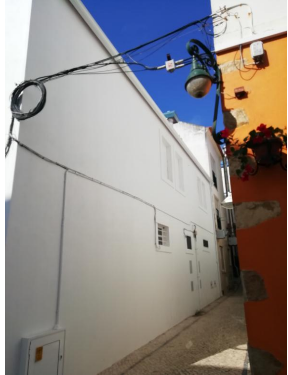
Foto n.º 2 – Vista da Fachada Norte
