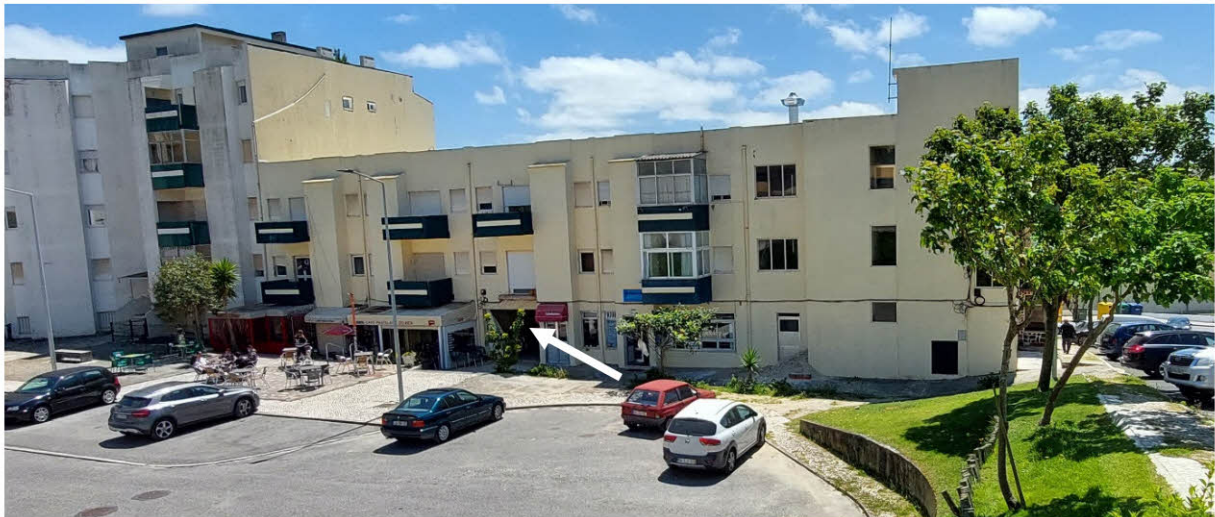
Figura 2.2 – Indicação da zona onde ocorreu o colapso da varanda
