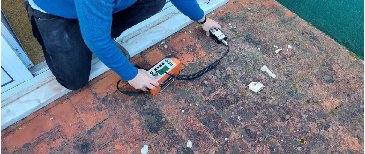
Figura 2.4 – Ensaio para deteção de armaduras
