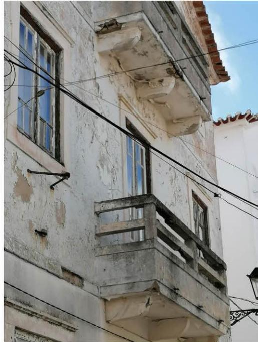
Foto 2 - Degradação dos corpos balançados - fachada poente.
