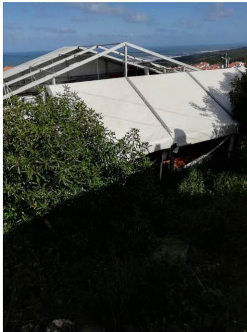
Foto n.º 1 – Tendões e/ou pavilhões implantados no logradouro do Museu
