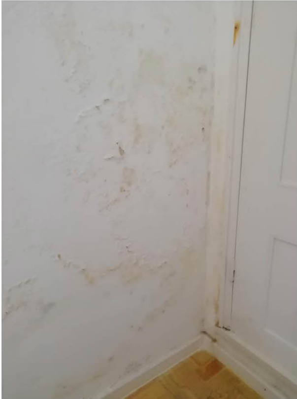
Foto n.º 1 – Vista interior da parede do quarto
