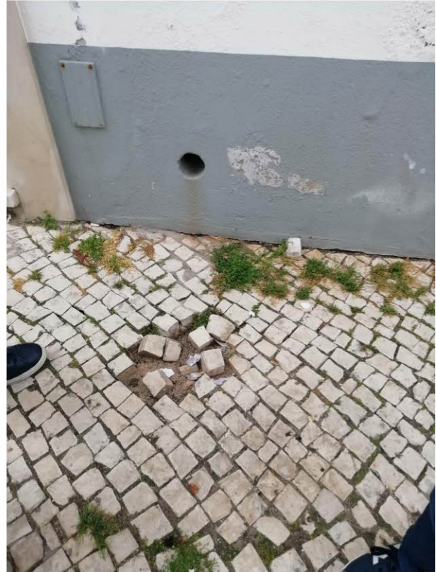
Foto n.º 2 – Vista exterior da parede do quarto
