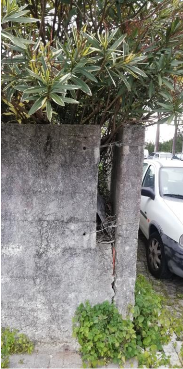
Foto n.º 1 – Vista do exterior do muro
