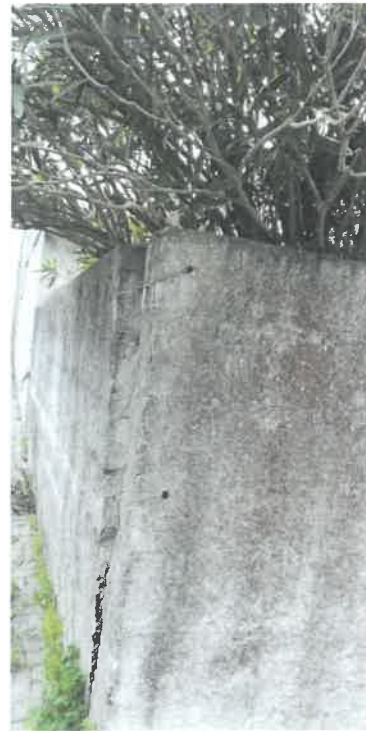
Foto n.º 2 – Vista do exterior do muro
