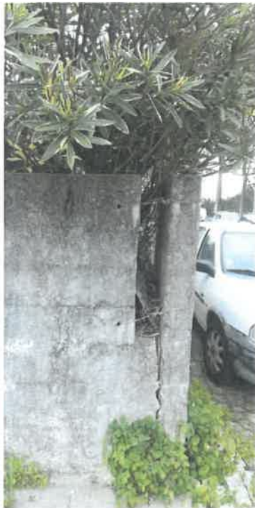
Foto n.º 1 – Vista do exterior do muro
