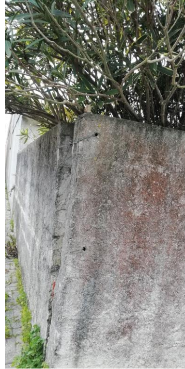
Foto n.º 2 – Vista do exterior do muro
