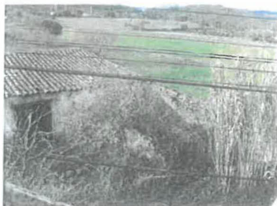
Foto n.º 4 – Ruína no logradouro a tardoz
