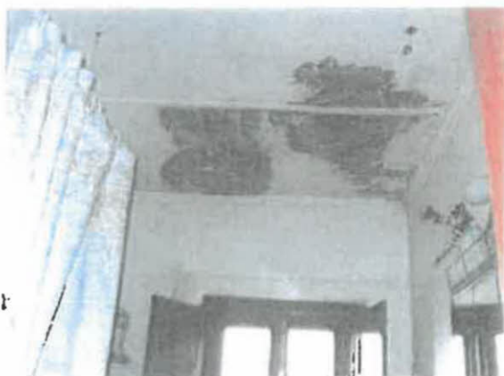
Foto n.º 3 - Interior da instalação sanitária
