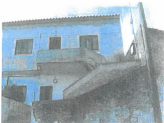
Foto n.º 1 – Fachada principal do fogo
