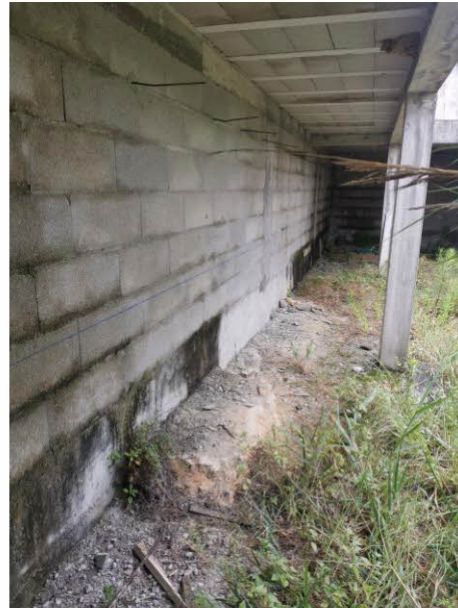
Foto n.º 2 – Vista de muro de alvenaria de blocos de cimento
