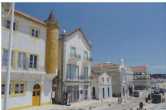
Figura 3 – Vista do edifício a partir da Marginal.
