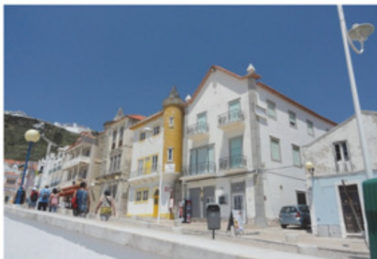
Figura 2 – Vista do edifício a partir da Marginal.
